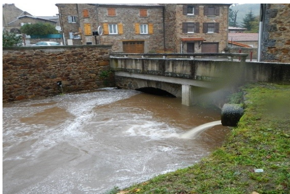
Entrée de la couverture – Photo du Syndicat des Trois Rivières (le 04/11/2014)
