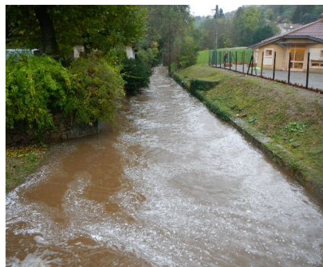
Entrée de la couverture – vue en amont – Photo du Syndicat des Trois Rivières (le 04/11/2014)
